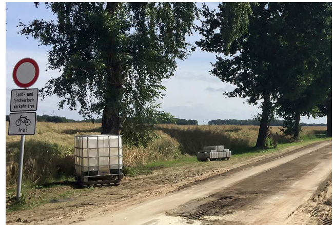
Abb. 2: Ländlicher Wegebau in der Flurbereinigung
