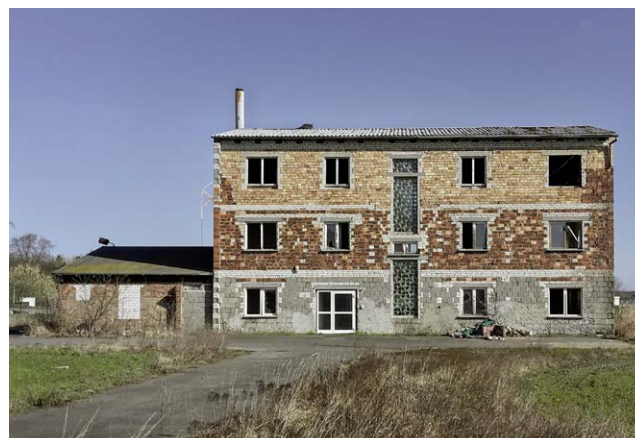
Abb. 1: Umlegungsbedingte Beseitigung eines leer stehenden Gebäudes
