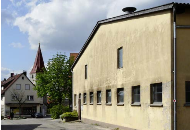
Abb. 2: Leerstehendes Stallgebäude in der Ortsmitte
