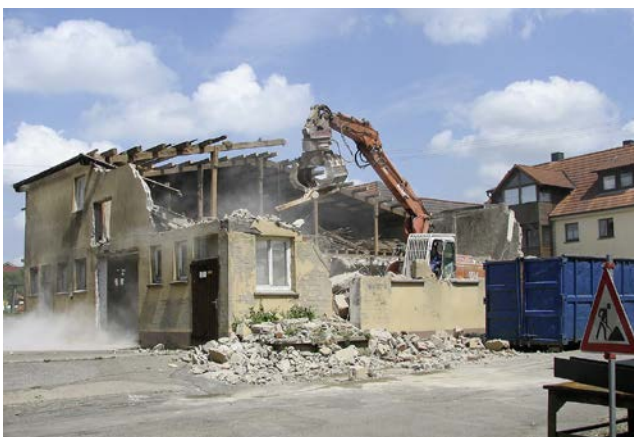
Abb. 6: Beginn der Abrissarbeiten zur Gestaltung des neuen Dorfplatzes
