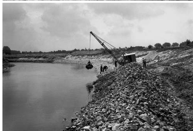
Abb. 2 und Abb. 3: Ausbau und Befestigung der Lippeufer; Aufnahmen vom 9.9.1958 und 18.7.1968
