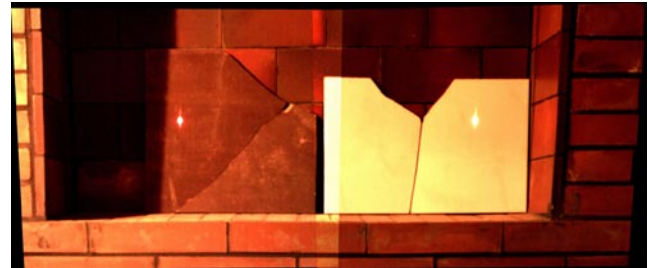
Abb. 8: Gerissene Kacheln, Rohbilder der Trimble VX Spatial Station
