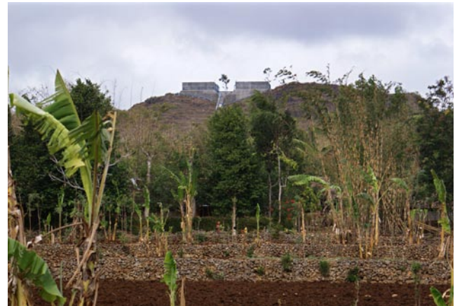
Abb. 5: Wasserspeicher im Wasserverteilungssystem Bribin
