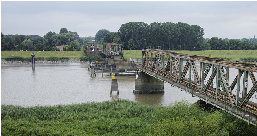
Abb. 12: Friesenbrücke Weener nach der Kollision
