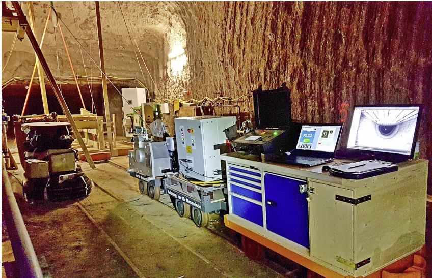
Abb. 5: Aufbau der Messsonde mit Messwinde am Schachtkranz
