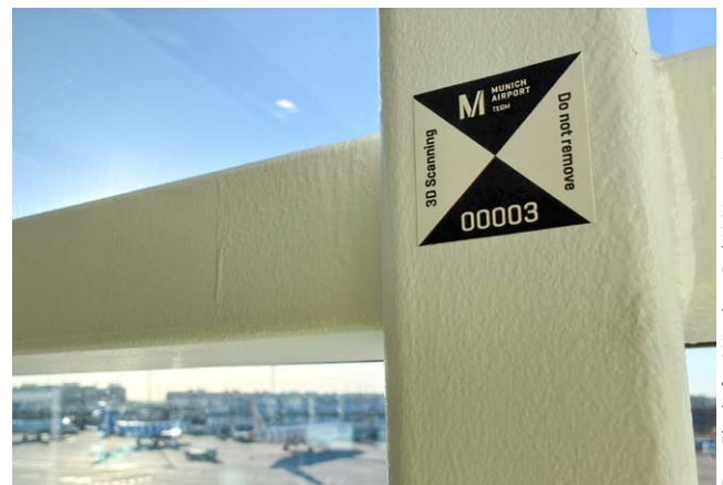
Abb. 2: Klebmarke zur Georeferenzierung der 3D-Laserscans
