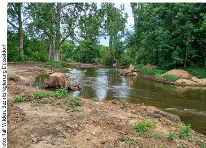
Abb. 6: Erftumbau zur Bauphase 2022
