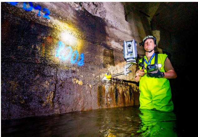
Abb. 3: Messung des Polygonzuges in der Gewässerverrohrung mit beweglichen Konsolen in entsprechender Schutz-ausstattung
