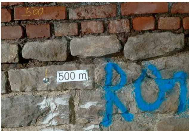
Abb. 2: Als Bolzen vermarkter und mit Plakette gekennzeichnete Messpunkt der Metrierung. Die verschiedenen Baumaterialien aus der Tunnelhistorie sind gut erkennbar.
