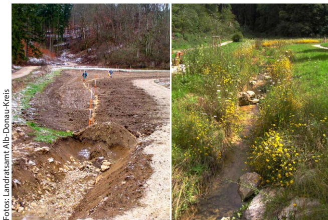
Abb. 9: Renaturierungsmaßnahmen an Gewässern verringern das Tempo des Wasserabflusses und sind damit geeignete und wichtige Maßnahmen in Flurneuordnungsverfahren. Links: Während der Umsetzung. Rechts: Nach der Umsetzung.
