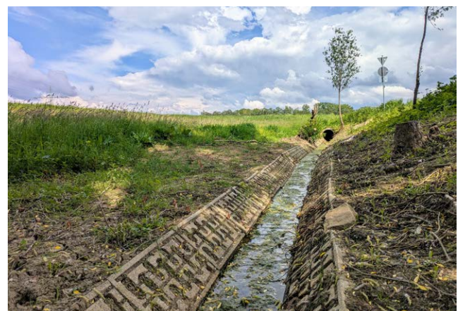
Abb. 6: Die mitteleuropäische Kulturlandschaft ist auf Entwässerung optimiert. Der technische Verbau von Gewässern untergeordneter Bedeutung trägt wesentlich dazu bei.
