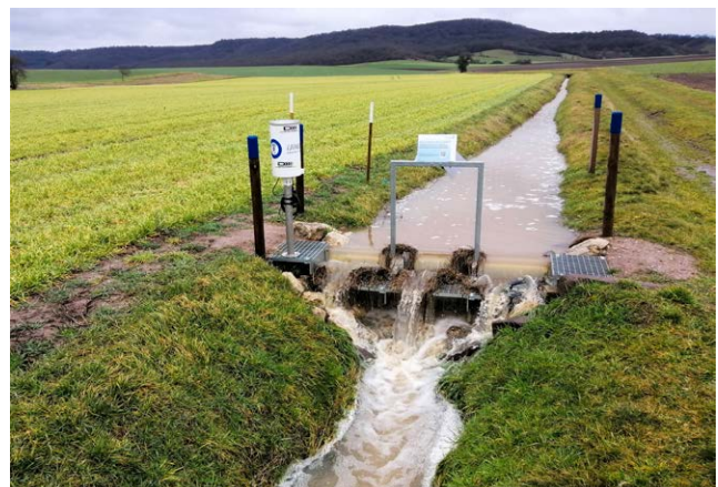
Abb. 8: Ein kontrollierter Grabeneinstau leitet Hochwasser verzögert ab und verbessert die Wasserverfügbarkeit im Umfeld durch Versickerung.
