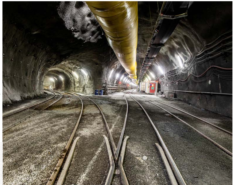
Quelle: BBT SE Brenner-Basistunnel Projektgesellschaft
