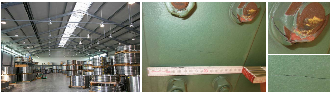
Abb. 1: Beispielhafte zu inspizierende Stahlhalle 1 (links) und mögliche Schäden an Stahlkonstruktionen 2 (Mitte) mit Detailansichten (rechts)
