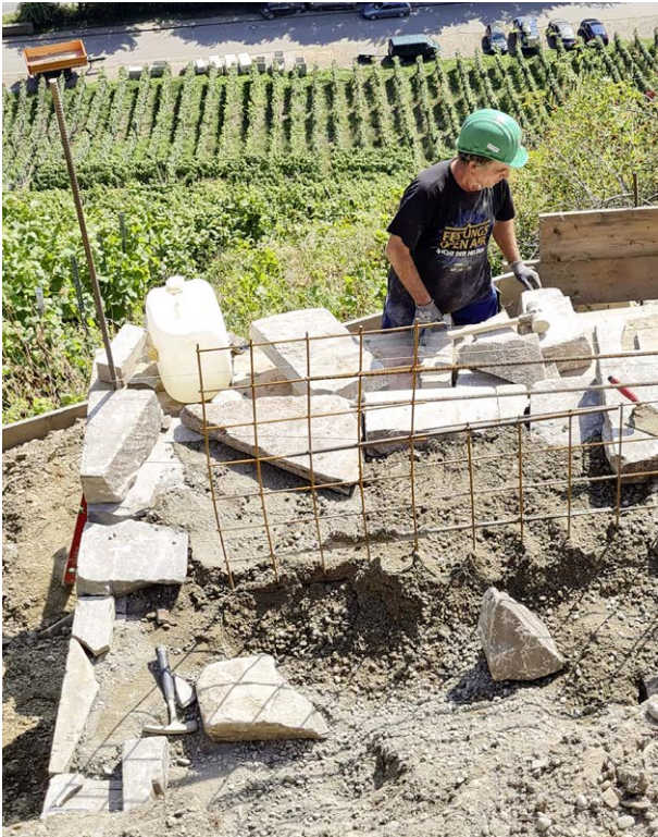
↑ Abb. 3: Bau einer Weinbergsmauer durch den Regiebetrieb
