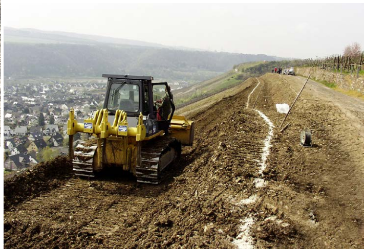
↗ Abb. 4 und → Abb. 5: Bau einer Querterrassierung in einer Weinbergsteillage durch den Regiebetrieb
