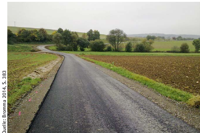
Abb. 2: Standardausbau eines Hauptwirtschaftsweges mit 3,5 m Fahrbahnbreite und für 11,5 t Achslast
