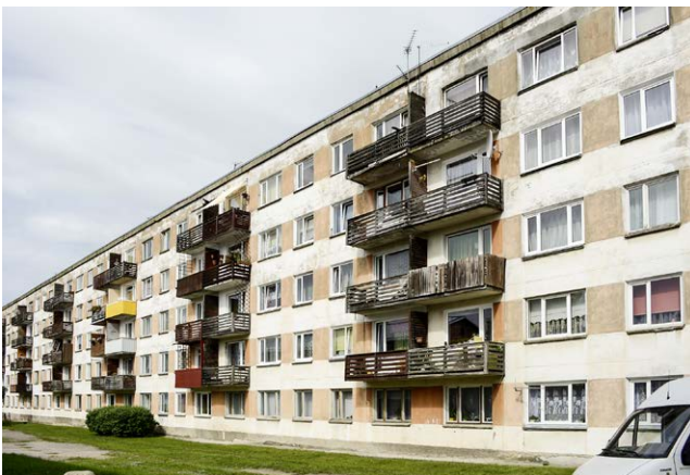
Abb. 8: Typisches Wohngebäude aus der Sowjetzeit
