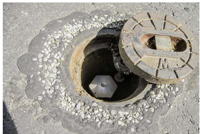
Abb. 2: Schachtbauwerk auf der Dammkrone zum Schutz der lage- und höhenmäßig definierten Objektpunkte
