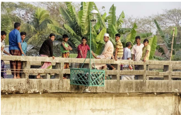
Abb. 7: Im Projekt installierte GNSS-Pegelstation Char-changa
