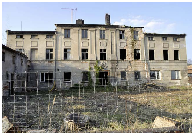
Abb. 1: Verfallenes Gebäude ohne Bestandsschutz
