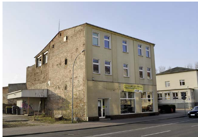
Abb. 3: Zum Rückbau wegen Neubebauung vorgesehene Gebäude mit Restnutzungsdauer
