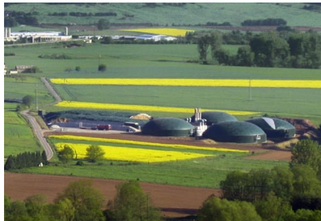
Abb. 2: Biogasanlage im Landkreis Bernkastel-Wittlich. Auf einer Fläche von rd. 4 ha produziert die Anlage 12 GWh Strom und 14 GWh Wärme (Erdgas) pro Jahr. Für den Betrieb werden rd. 1000 ha landwirtschaftliche Nutzfläche benötigt.
