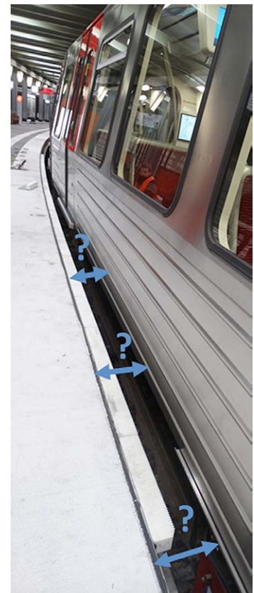
Abb. 1: Spalt zwischen U-Bahn und Gleisen nach dem Einbau der Gap-Filler an der Haltestelle Klosterstern in Hamburg
