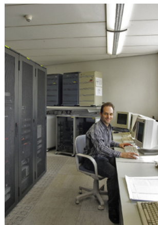
Abb. 11b: GPS-Operationszentrum Wettzell, Blick in den Messraum
