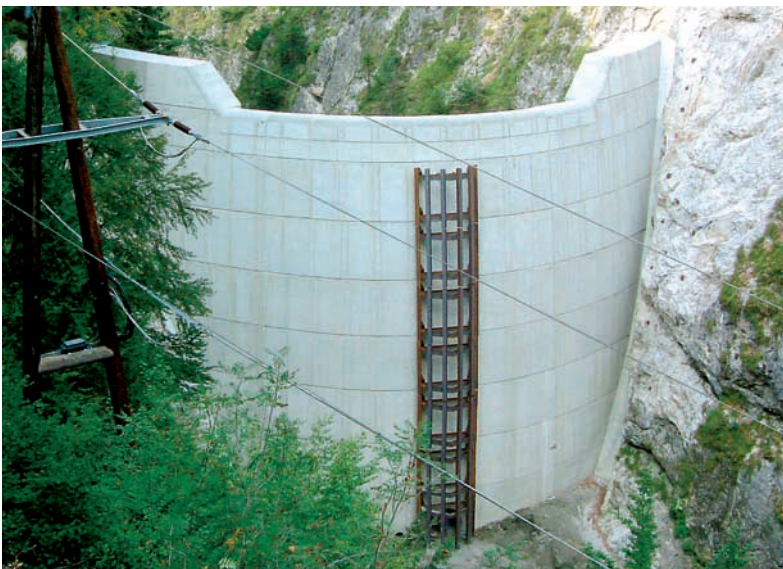
Abb. 3: Sperre Wörglerbach, Ansicht vom wasserseitigen Messpfeiler
